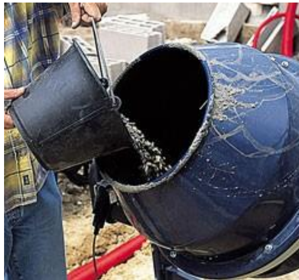
Dosage béton bétonnière à l'aide d'un seau de maçon.
